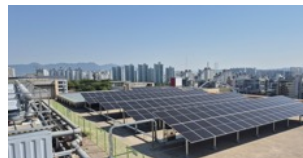
[롯데쇼핑] 태양광 패널 설치
