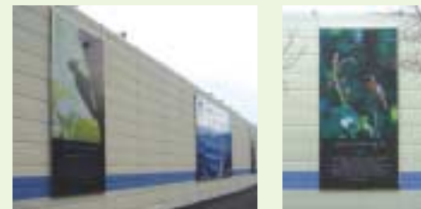
부산 광복점 공사현장 외벽
